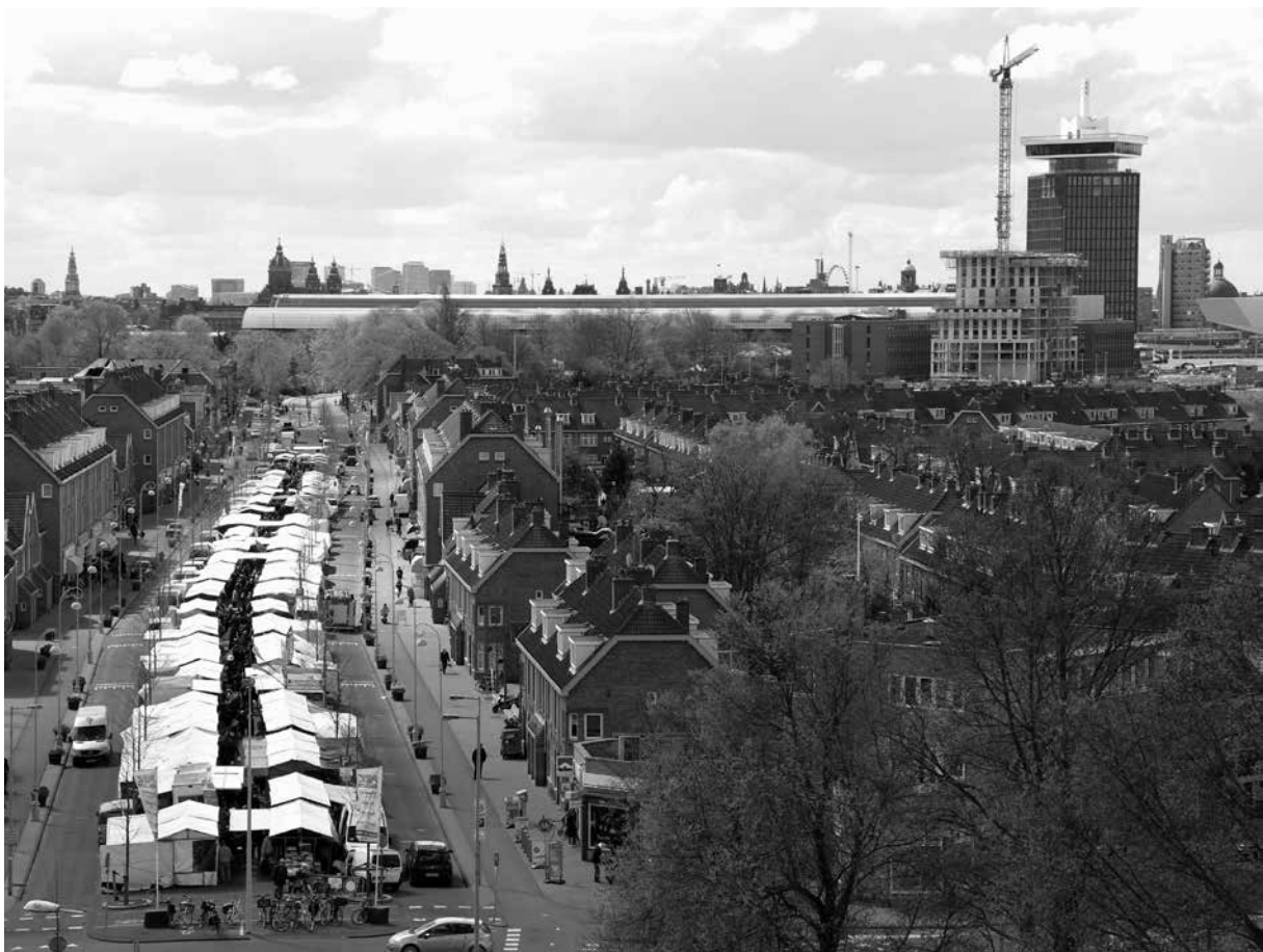
Amsterdam, Van de Pekbuurt met op de achtergrond bouwactiviteiten aan de Noordelijke IJ-oever en het Centraal station (foto: Thomas van Mens)
