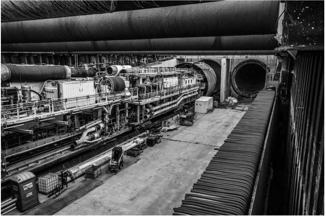
De aanleg van de Rotterdamsebaan, met een boortunnel onder Voorburg-West door, vordert gestaag (foto: Frank Jansen/Gemeente Den Haag)
