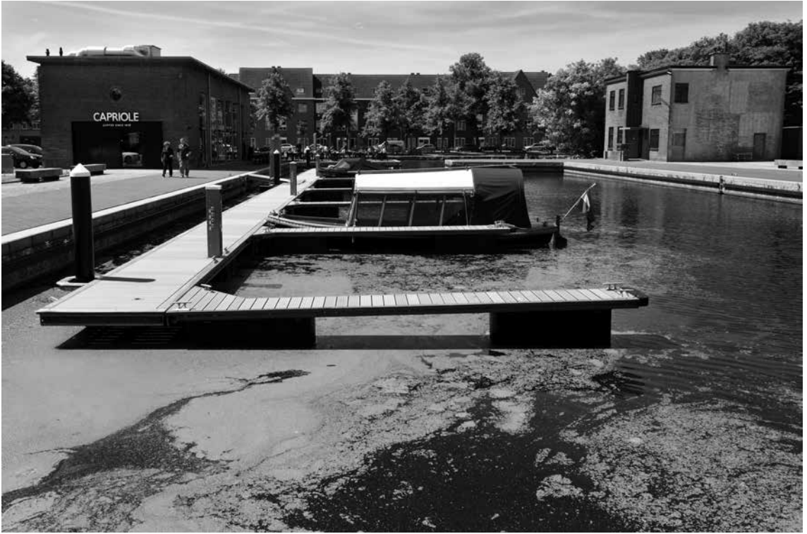
De Fokkerhaven is aangelegd als watercompensatie. Met de horeca aan de haven is een levendige plek ontstaan in het hart van de Trekvlizzone (foto: Jurriaan Brobbel/Gemeente Den Haag)
